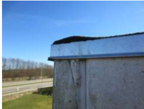
Tagpappet slipper på sternkanten flere steder
